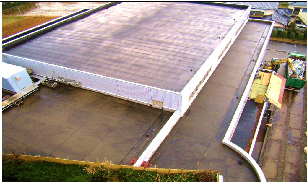
施工現場全景
