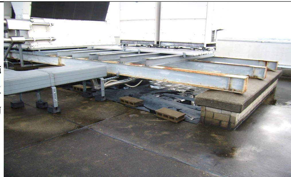
ドレン周り、部分処置部分
