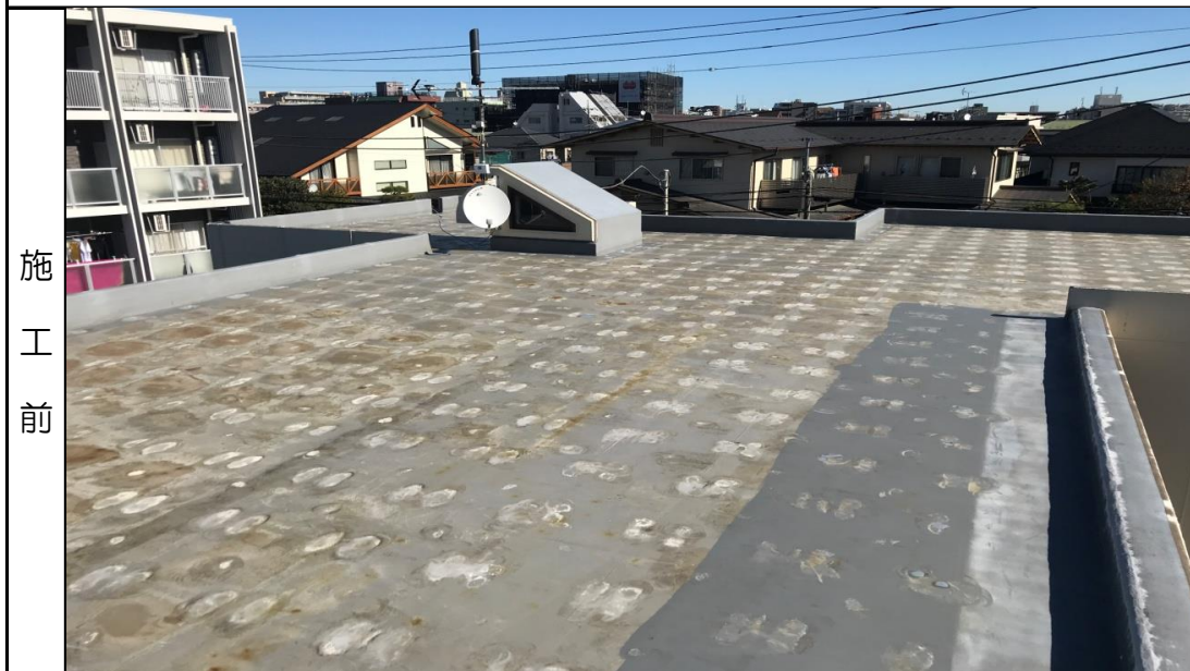
施工現場全景
