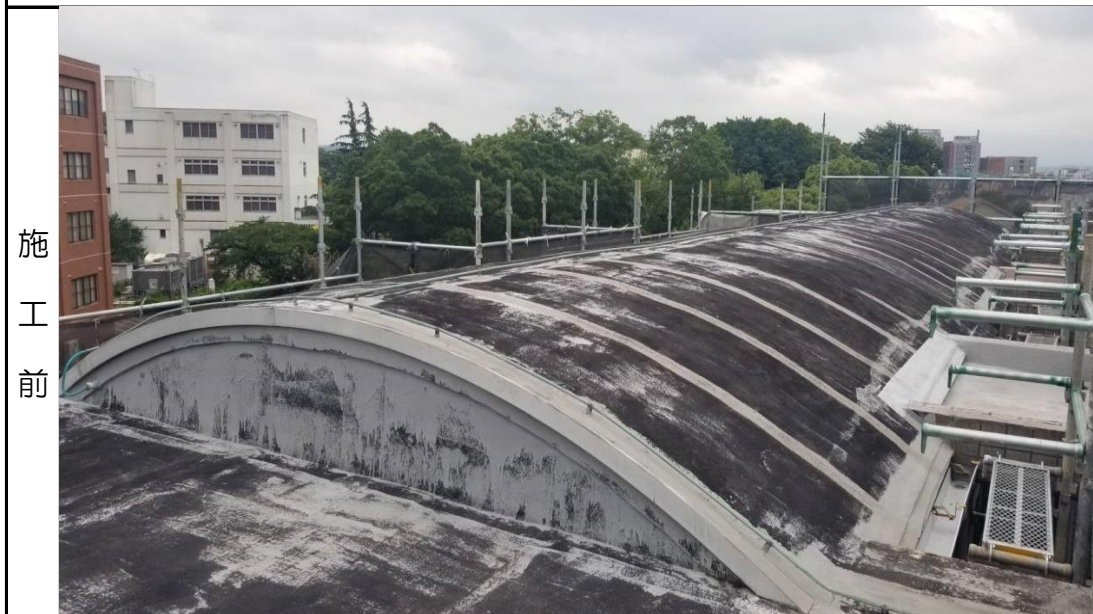
施工現場全景
