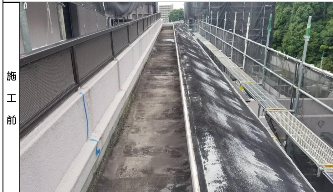
ドレン周り、部分処置部分
