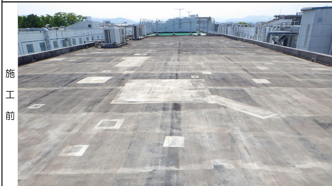
施工現場全景
