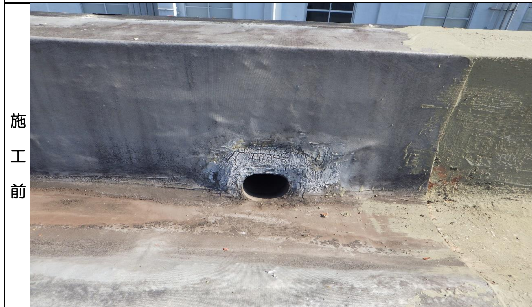
ドレン周り、部分処置部分
