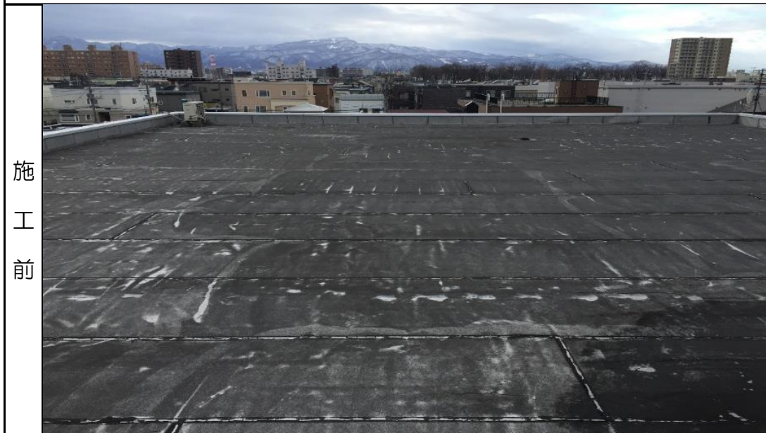
施工現場全景
