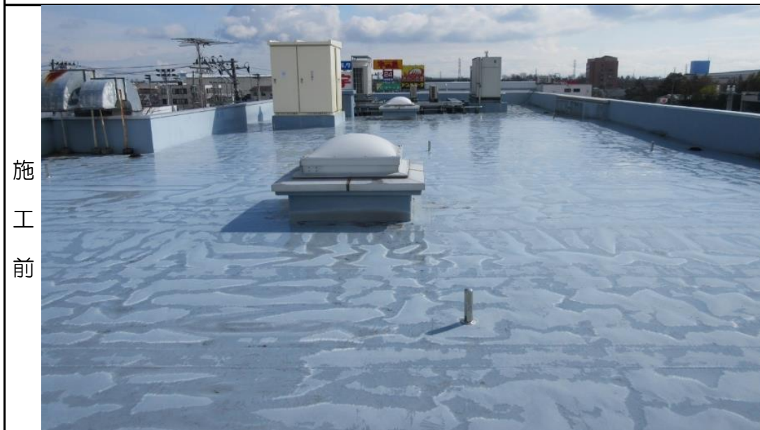
施工現場全景
