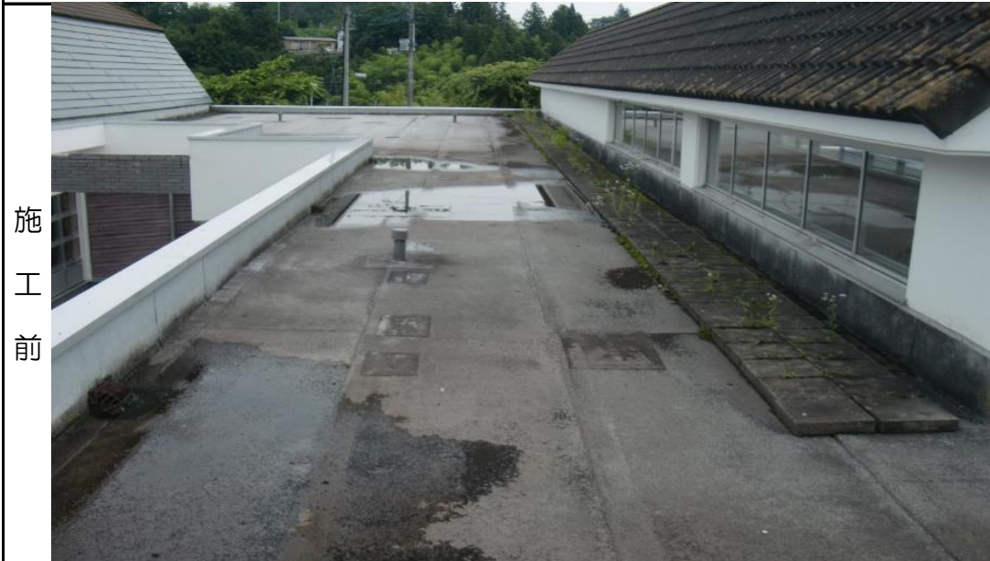
施工現場全景
