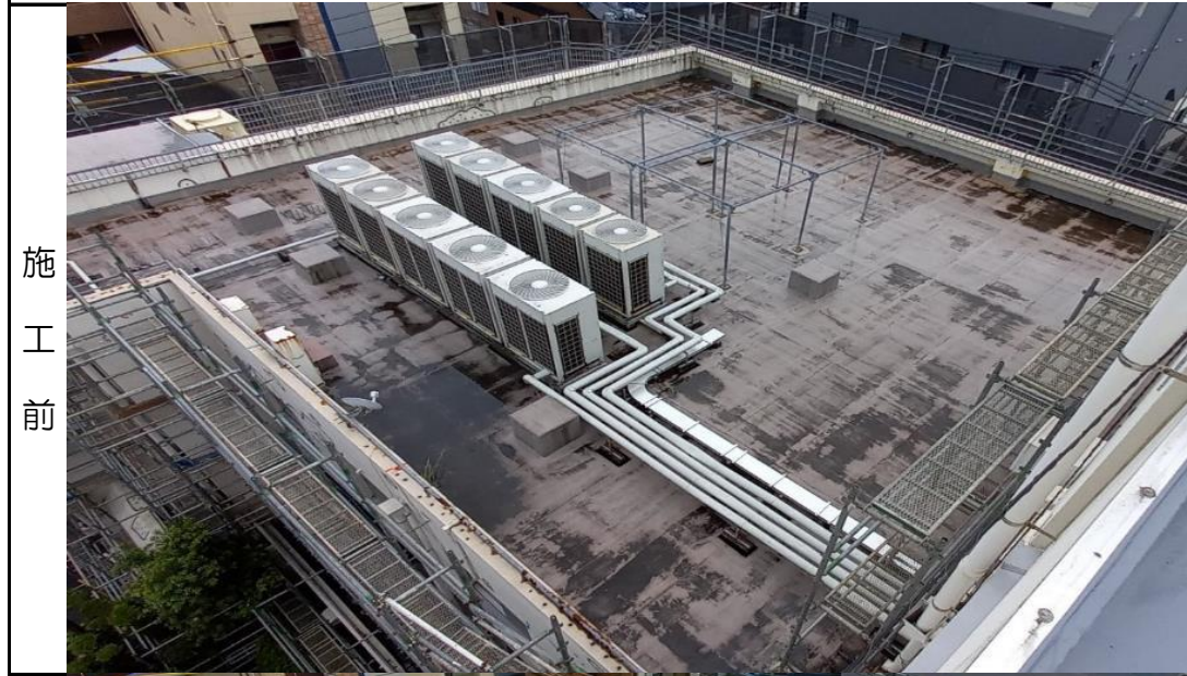
施工現場全景
