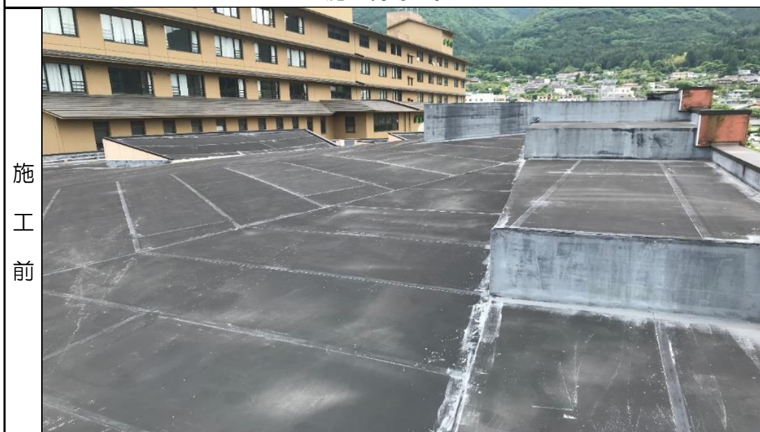
施工現場全景
