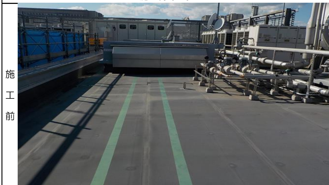
施工現場全景
