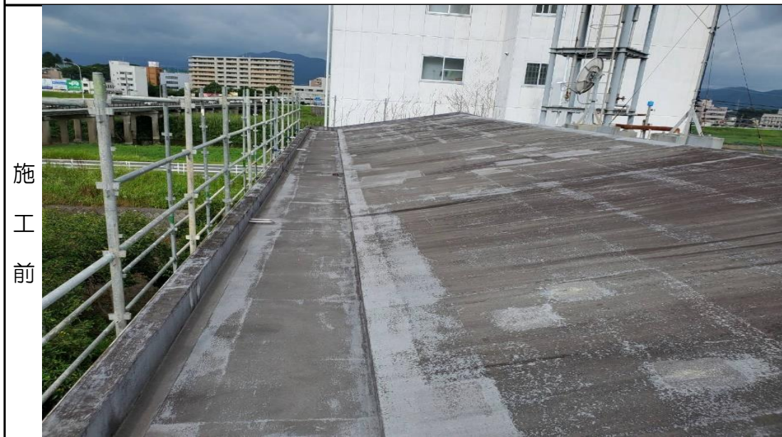
施工現場全景
