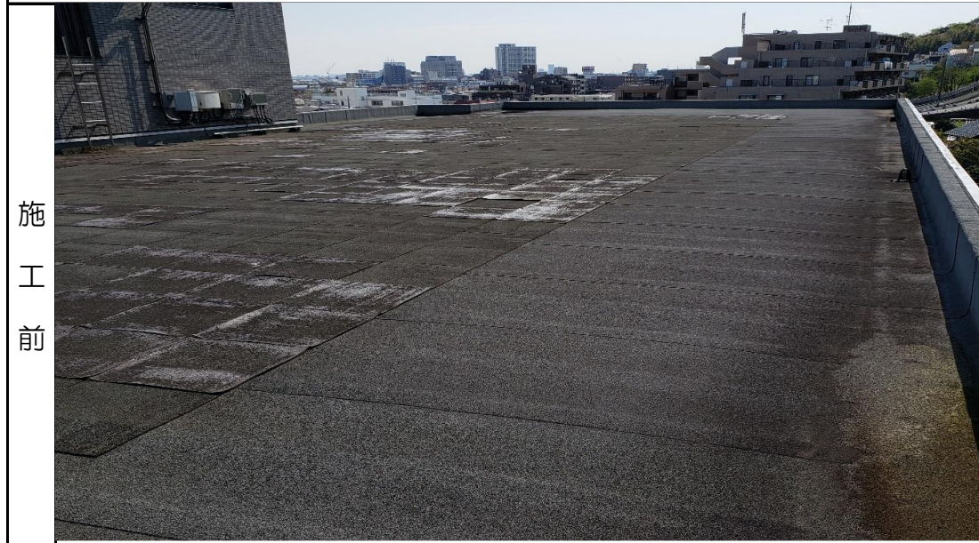
施工現場全景
