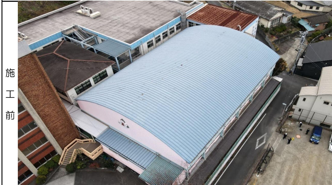
施工現場全景
