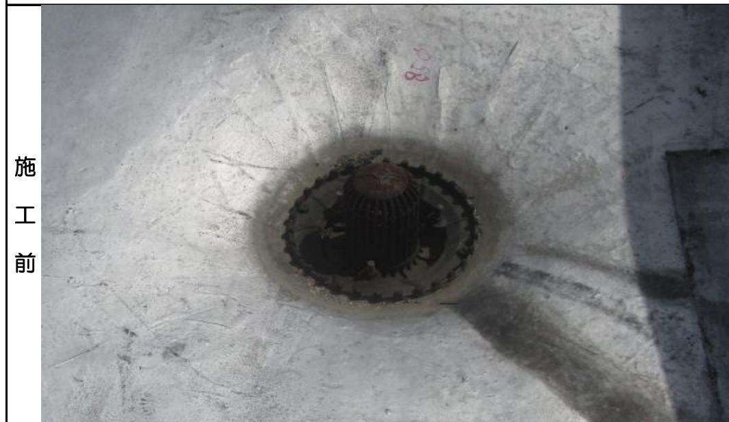
ドレン周り、部分処置部分
