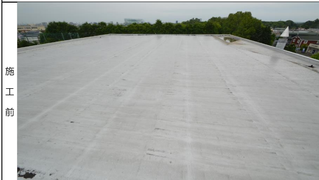
施工現場全景
