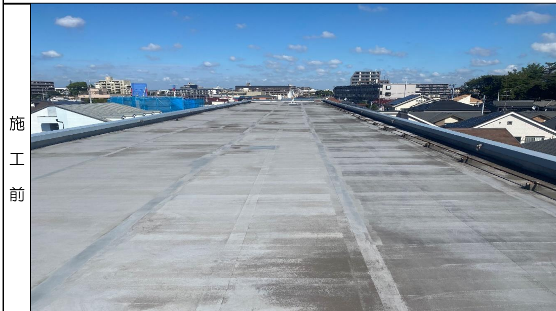
施工現場全景
