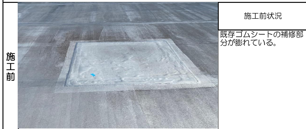
ドレン周り、部分処置部分
